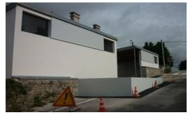
La remise aux normes d'accessibilité a nécessité la pose d'un ascenseur qui dessert les classes à l'étage et la sécurisation des accès de l'école avec la création d'une nouvelle entrée.
