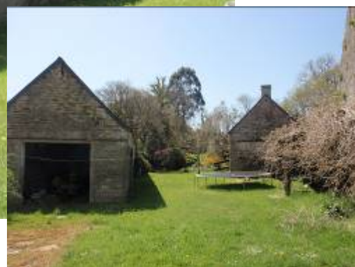
Bâtiment 1 – photo 3 (environnement)
