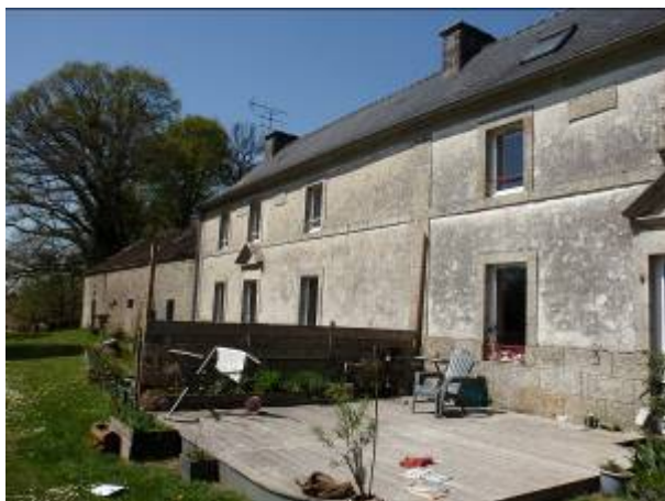
Bâtiment 2 – Photo 5 (environnement)
