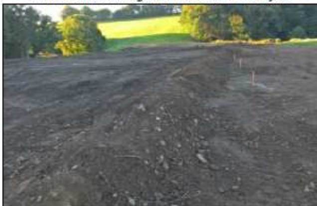
Couche de terre végétale sur zone remblayée
